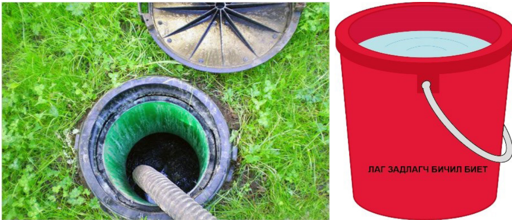
Зураг 11. Өөр септикээс бичил биет бүхий биет бохир ус авчирч нэмэх (Жишээ зураг)
